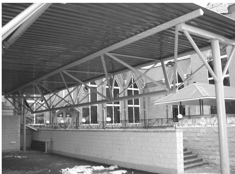
Рис. 8.35. Трехгранные фермы в покрытии (Томск, 2000 г.)
